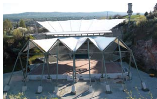
Rozsuwany dach membranowy nad Amfiteatrem „Kadzielnia” w Kielcach
