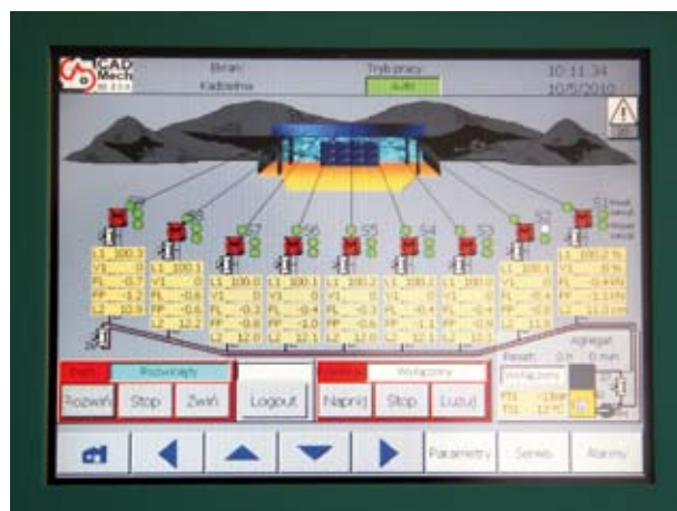
Panel sterowania systemem do rozsuwania dachu membranowego w Amfiteatrze Kadzielnia w Kielcach
